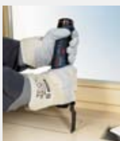
Lavori di taglio, levigatura e adattamento* I professionisti degli spazi ridotti.
